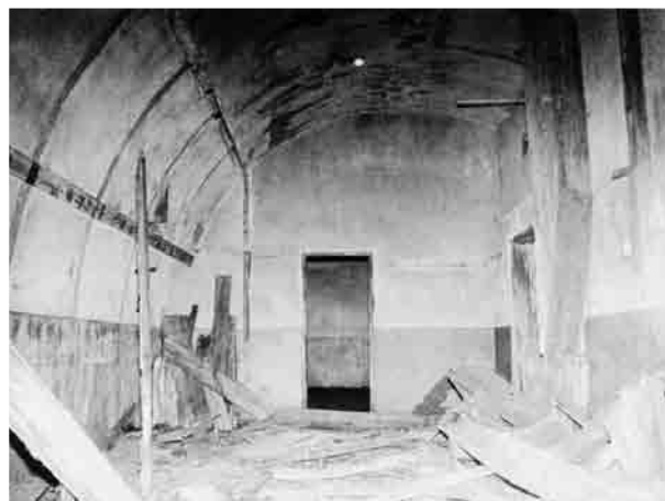
立山防空壕内部
