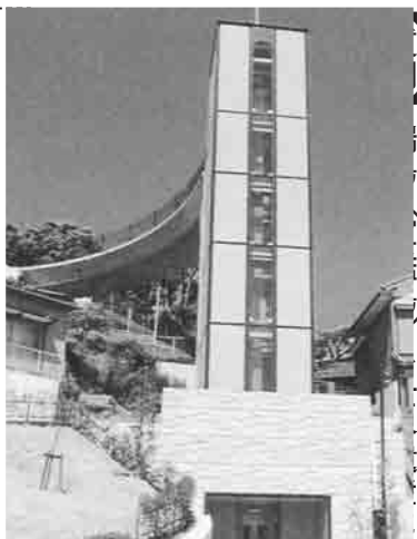
垂直エレベーター
