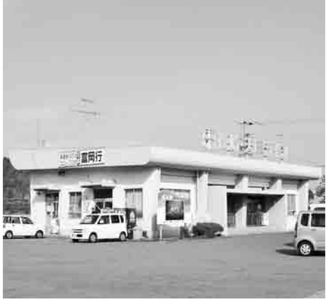
改修される待合室
